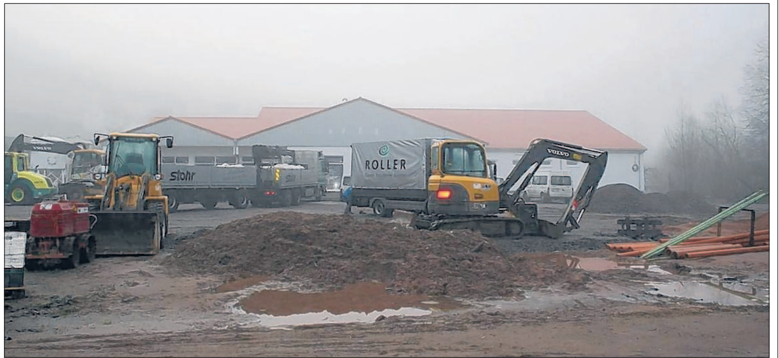
Noch stehen die Bagger vor dem Netto-Markt, der im kommenden Frühjahr in Bundenthal eröffnet werden soll. (Foto: Hagen)
