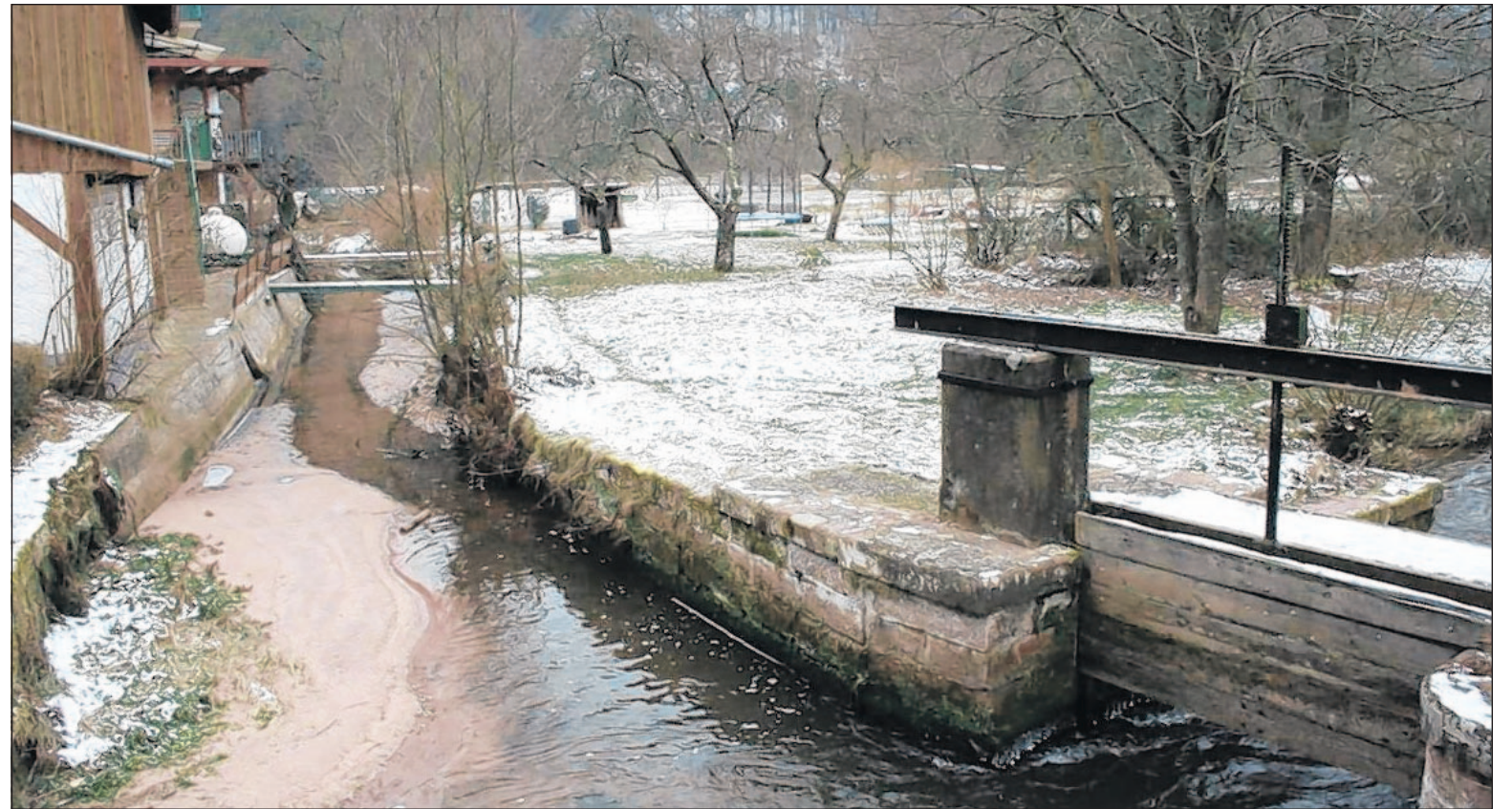
Unter der Schließe fließt die Wieslauter durch – ist sie geöffnet, wird der alte Be- und Entwässerungsgraben nur ungenügend mit fließendem Wasser versorgt. (Foto: Hagen)
