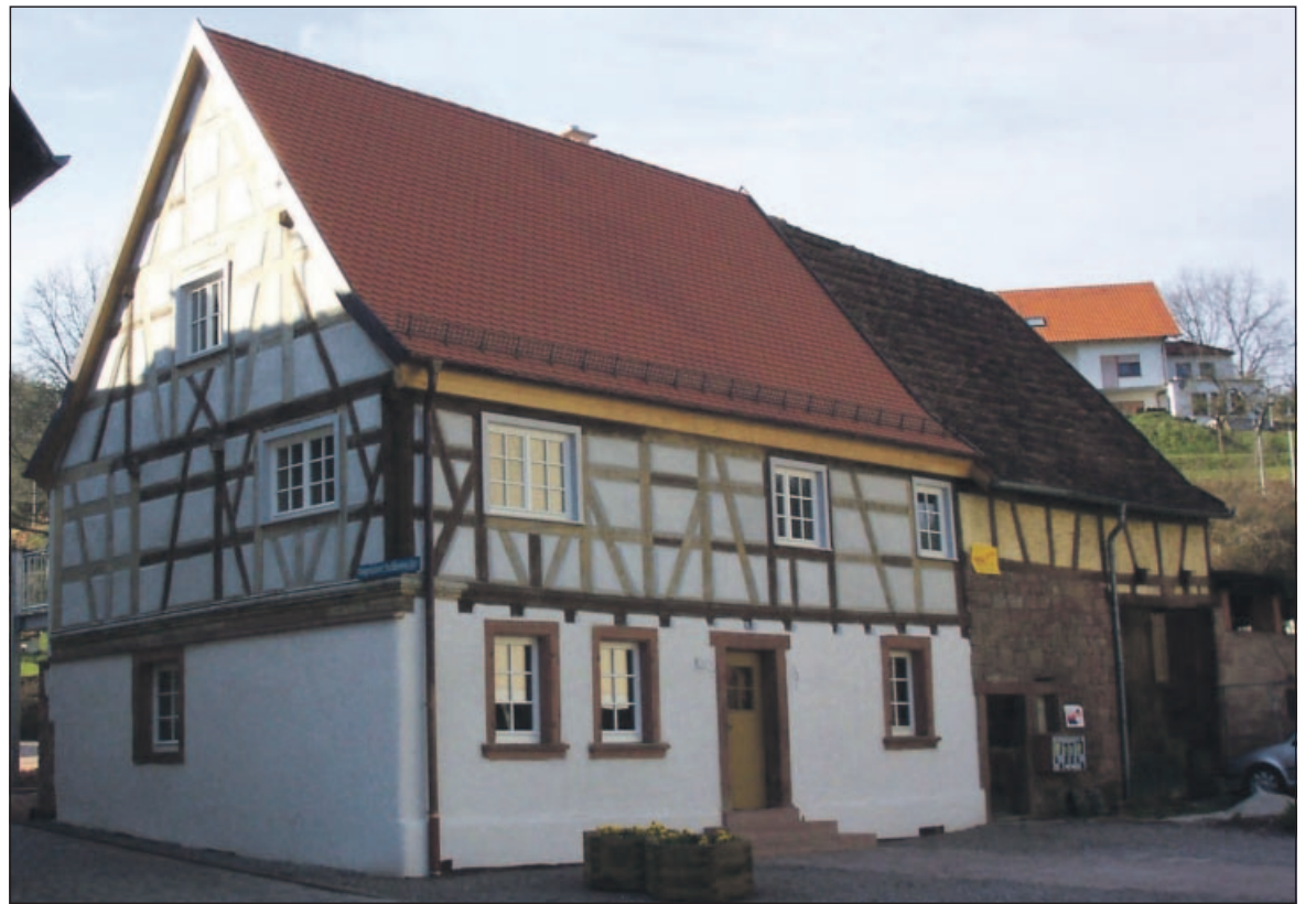
Nach Fertigstellung des ersten Bauabschnitts konnte der linke Flügel des ehemaligen „Schuhfritzens Hauses“, das von der Gemeinde heute als Dorfgemeinschaftshaus genutzt wird, 2003 in Betrieb genommen werden. (Foto: Hagen)
